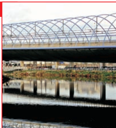
Tramo Sta. Teresa-Urbinaga, metro Bilbao
