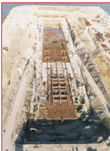
Construcción del Dique flotante de La Condomine
